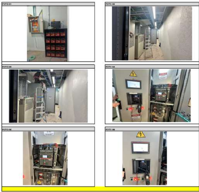
Reforma da subestação Fonte: Arquivos da Gerência Administrativa do HU-Furg.
