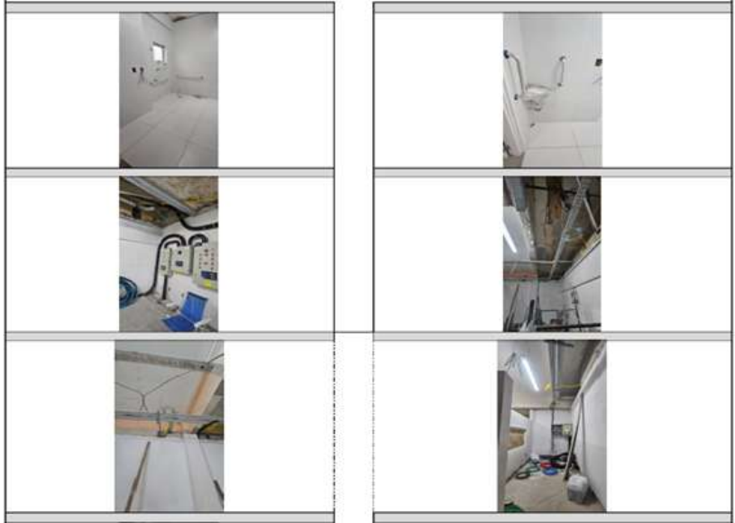
Obra Sala do raio-x Fonte: Arquivos da Gerência Administrativa do HU-Furg.
